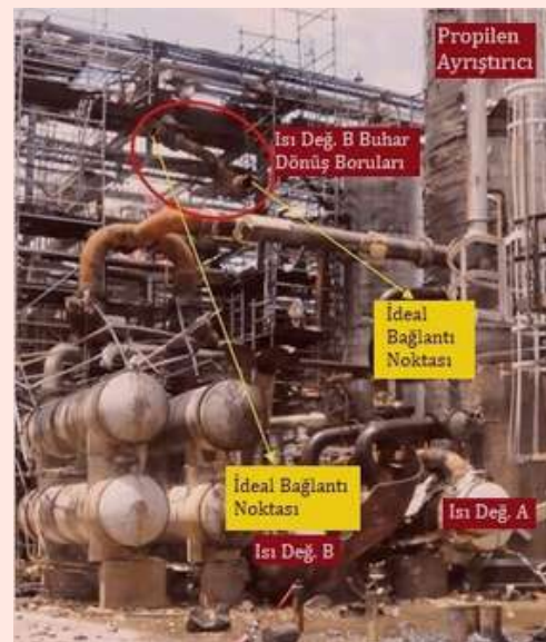
Şekil 2: Kazadan Sonra Propilen Ayrıştırıcı ve Isı Değiştirgeçlerinin Görünümü [2]
