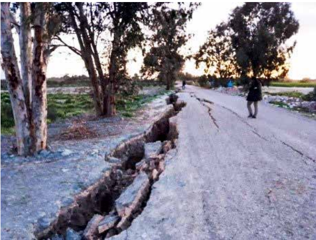
Şekil 3. Samandağ Spor salonu civarında zeminde oluşan sıvılaşma etkileri a) Yanal yayılma b) Kum fıskırmasını gösterir. © Halil Yıldız
