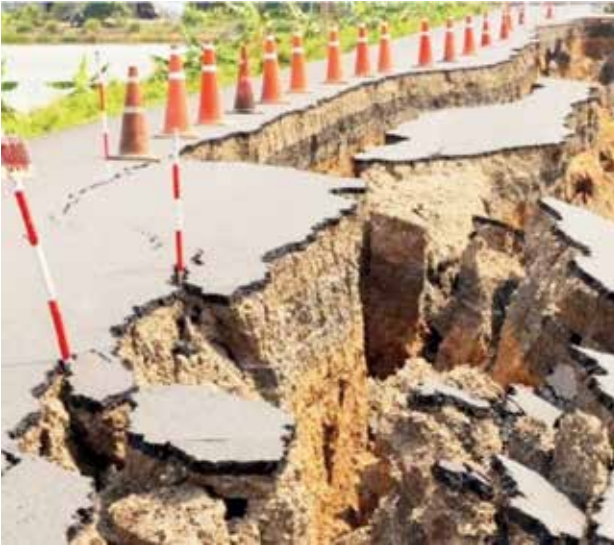
Foto 3: Otoyollarda meydana gelen deformasyonlar.
