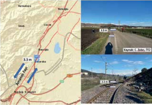
Şekil 5. Kahramanmaraş Şekeroba ilçesi kuzeybatısındaki yolu ve tren rayını kesen yüzey kırığı (fay) (22, 23).
