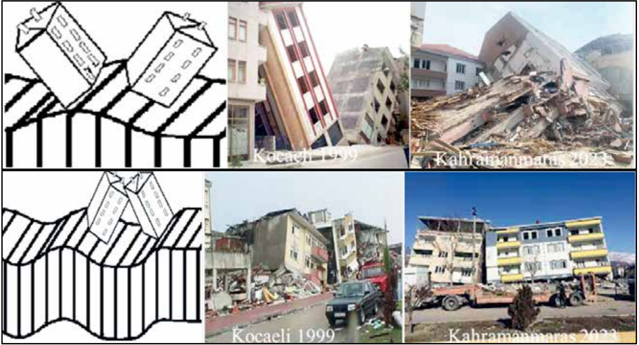
Şekil 1. Depremde meydana gelen SH dalgasının neden olduğu hasar örnekleri.
