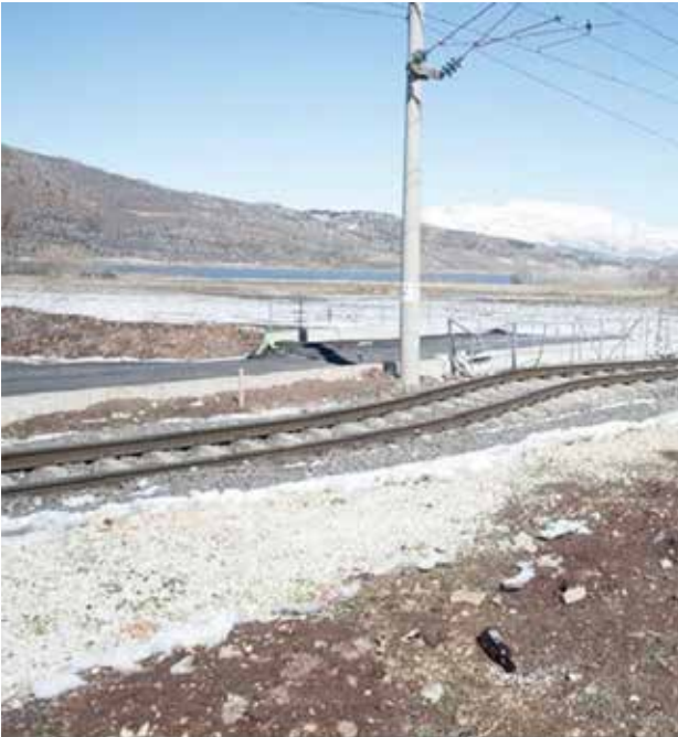
Foto 4: Adıyaman - Gölbaşı Tren İstasyonunda meydana gelen deformasyonlar.
