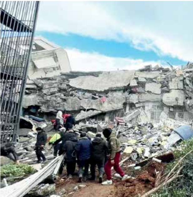
Foto 1: İskenderun Devlet Hastanesi Yoğun Bakım ve Fizik Tedavi Polikliniği Binası (Fay Sakınım Bandı Üzerindeki Binalar).
