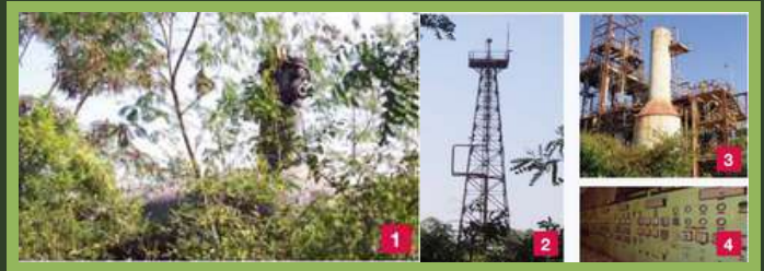
Şekil 2) 1. MIC Depolama tankı 2.MIC'in serbest bırakıldığı yer 3. Sodyum Hidroksit yıkayıcı (olay anında çalışmıyordu) 4.Kontrol odasının görüntüsü [4]
