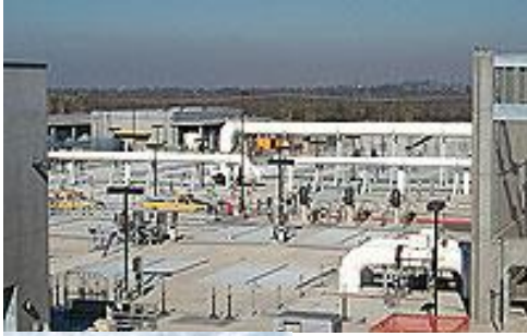
Çökeltme Havuzları Fotoğrafı
