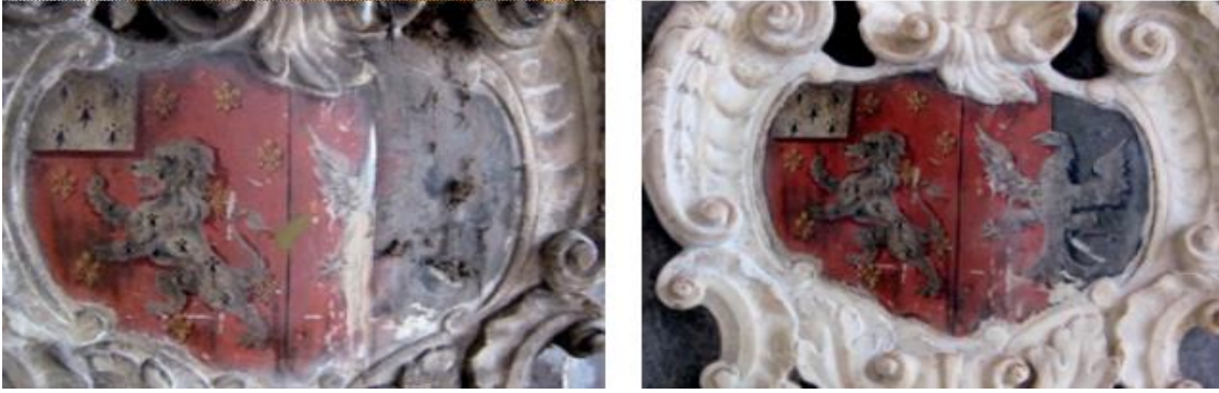
1780'lerden kalma bir anıt üzerindeki ince işçilikle yapılmış mermer kabartmanın, tozları gidermek amacıyla yapılan temizlemeden önceki ve sonraki görünümü.
