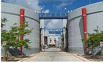
Anaerobik Digester Fotoğraf
