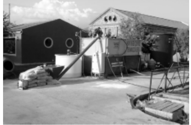
Şekil 1. Zeytin karasuyu arıtma tesisi genel görünümü.
